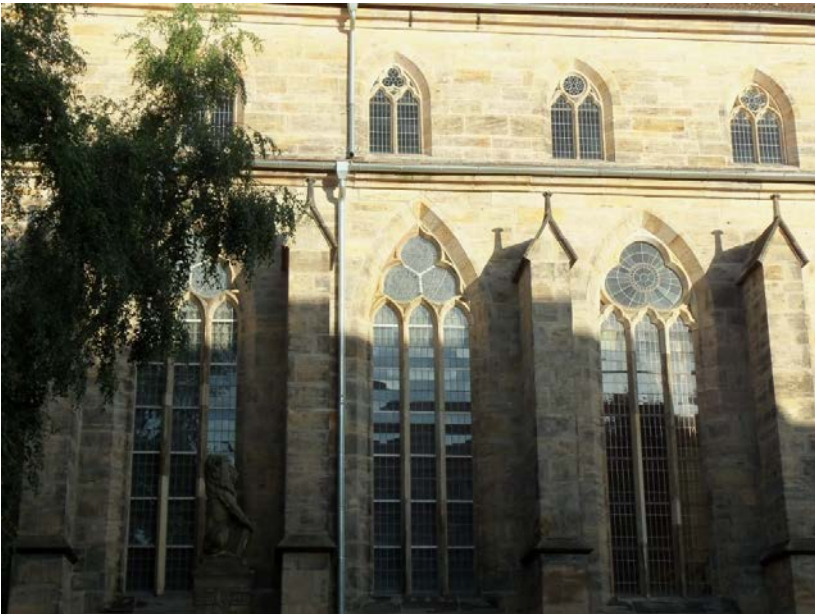
Abb. 3: Maßwerkfenster mit verschiedenen Formen. Langschiff der Predigerkirche, Erfurt. (Baubeginn ab ca. 1265, Langhaus bis 1390; vgl. Bürger 2011, S. 85)
