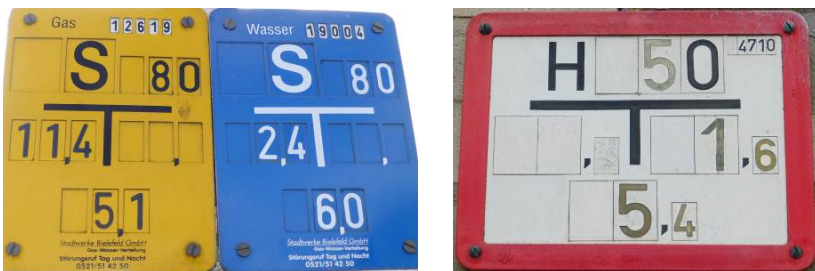
Abb. 3: Hinweistafeln an Hauswänden für Gas- und Wasseranschlüsse
