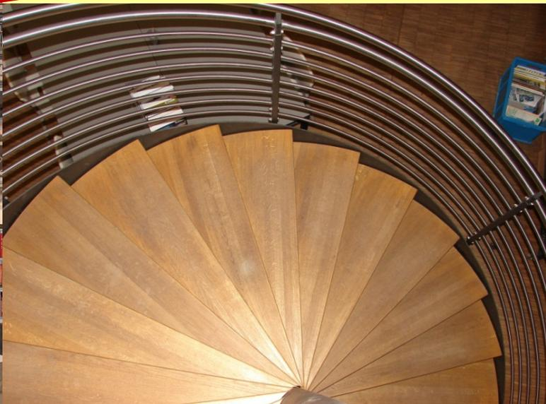
Eine Wendeltreppe kann man sich durch gleichzeitiges Schieben und Drehen eines Quaders entstanden denken.
