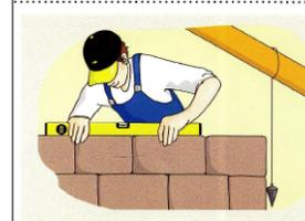
Der Maurer prüft mit der Wasserwaage und dem Lot, ob eine Mauer genau **waagrecht** und **lotrecht** ist.
